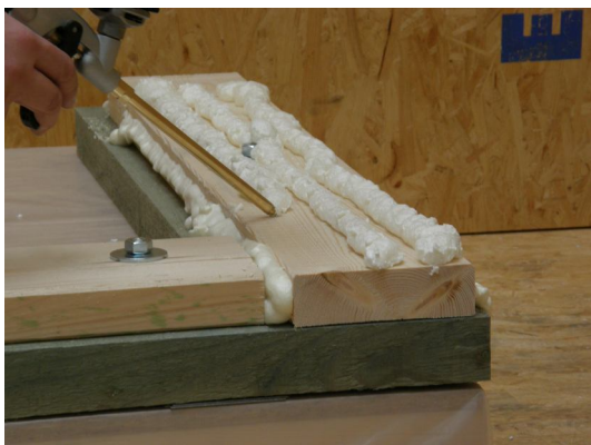
Obrázek 27: Aplikace PU pěny a lepidla pro založení prvního rohu.
