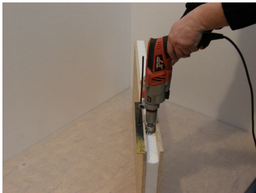
Obrázek 13: Frézování obvodové montážní drážky ocelovým kartáčem do panelu HobbyDek EP65.
