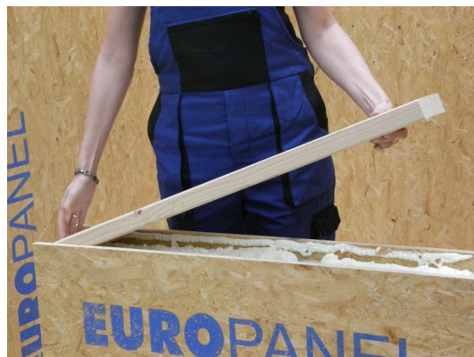
Obrázek 28: Příprava přisazeného panelu pro první roh.
