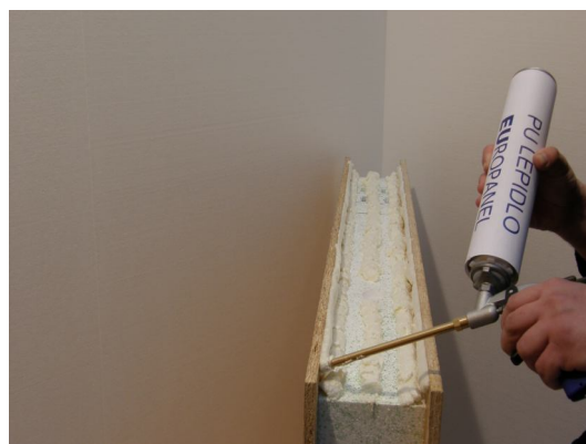
Obrázek 19: Aplikace PU lepidla na hranu drážky panelu.
