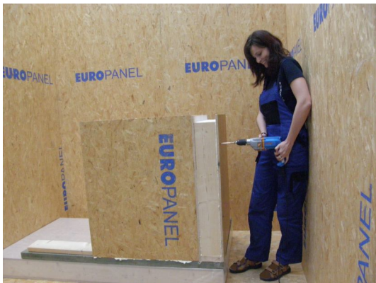
Obrázek 31: Spojení panelů v rohu pomocí SV-P.
