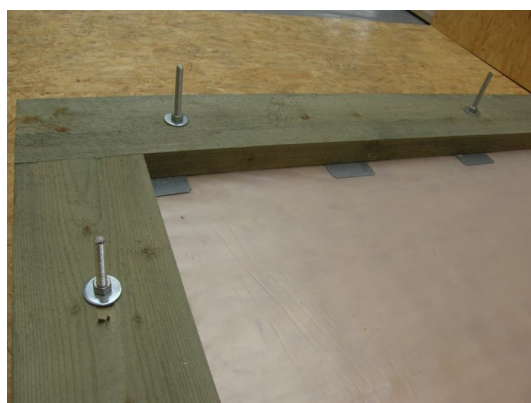
Obrázek 24: Vyrovnání základových pražců do vodorovné roviny (schematický obrázek).
