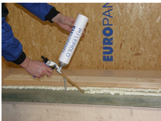
Obrázek 25: Aplikace PU lepidla mezi základový pražec a vložený prvek (schematický obrázek).
