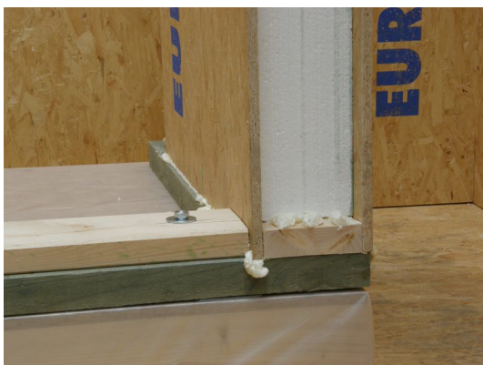
Obrázek 29: Usazený průběžný panel prvního rohu.
