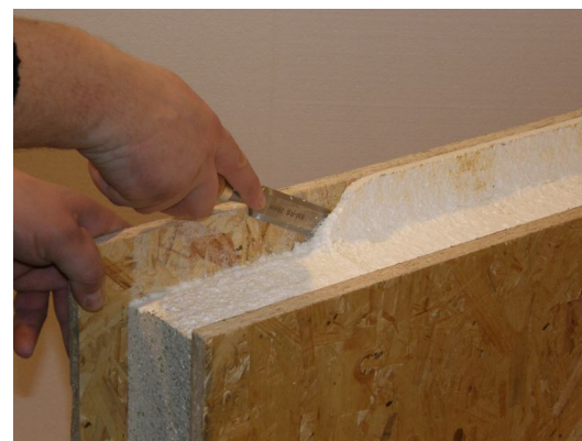
Obrázek 17: Odstranění zbytků EPS a lepidla dlátem.
