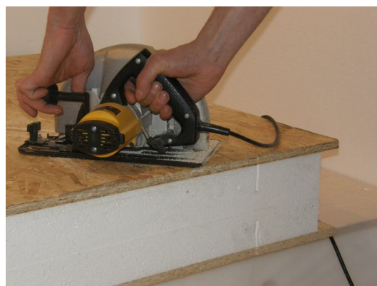
Obrázek 6: Proříznutí OSB desky panelu z druhé strany.
