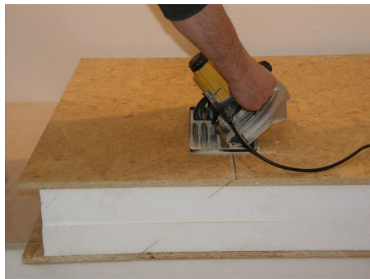
Obrázek 10: Řezání OSB desky panelu pod úhlem z druhé strany.
