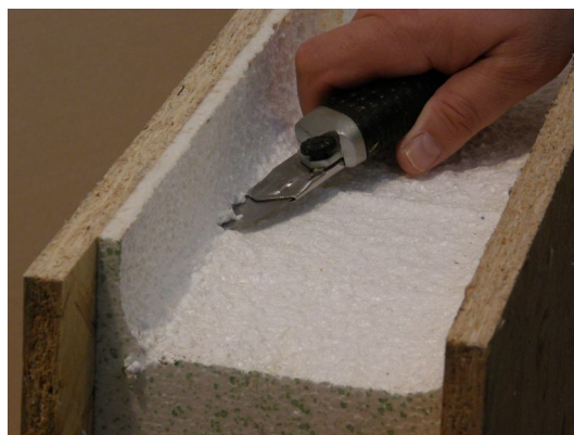
Obrázek 16: Seříznutí vnitřního rohu drážky nožem do roviny.
