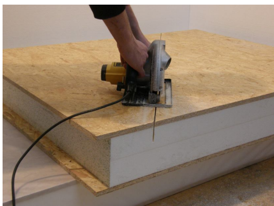
Obrázek 5: Proříznutí OSB desky panelu ruční kotoučovou pilou.
