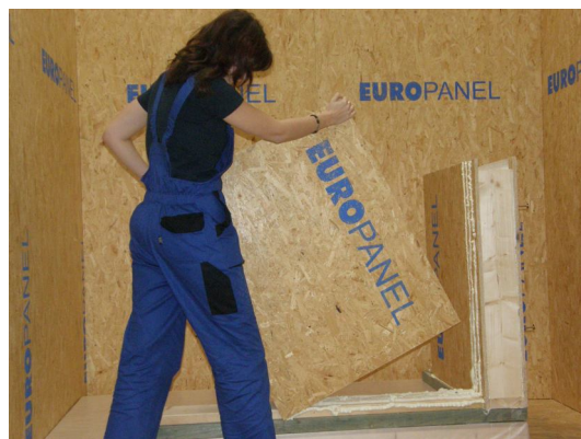
Obrázek 30: Usazení přisazeného panelu pro první roh.
