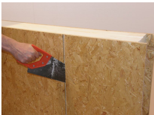
Obrázek 11: Dořiznutí EPS pod úhlem ruční listovou pilou.
