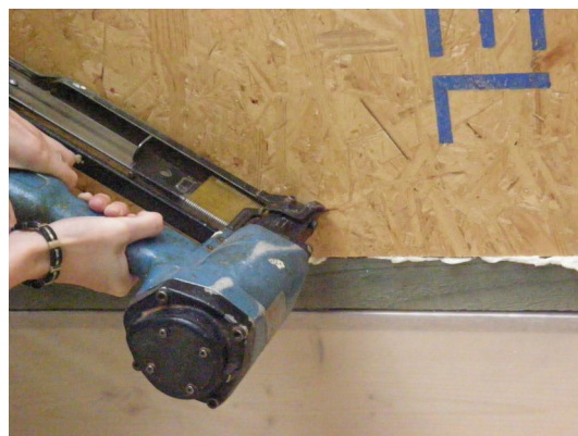
Obrázek 32: Zajištění spojů panelů sponami.
