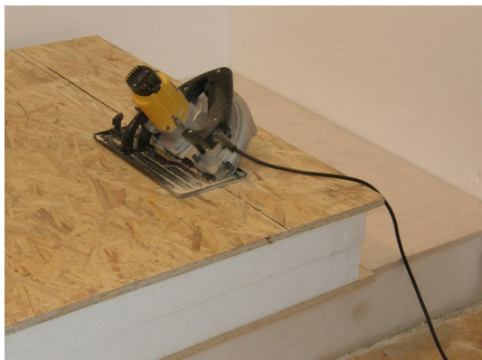
Obrázek 9: Úprava šikmo seříznuté hrany - řezání horní OSB desky panelu.
